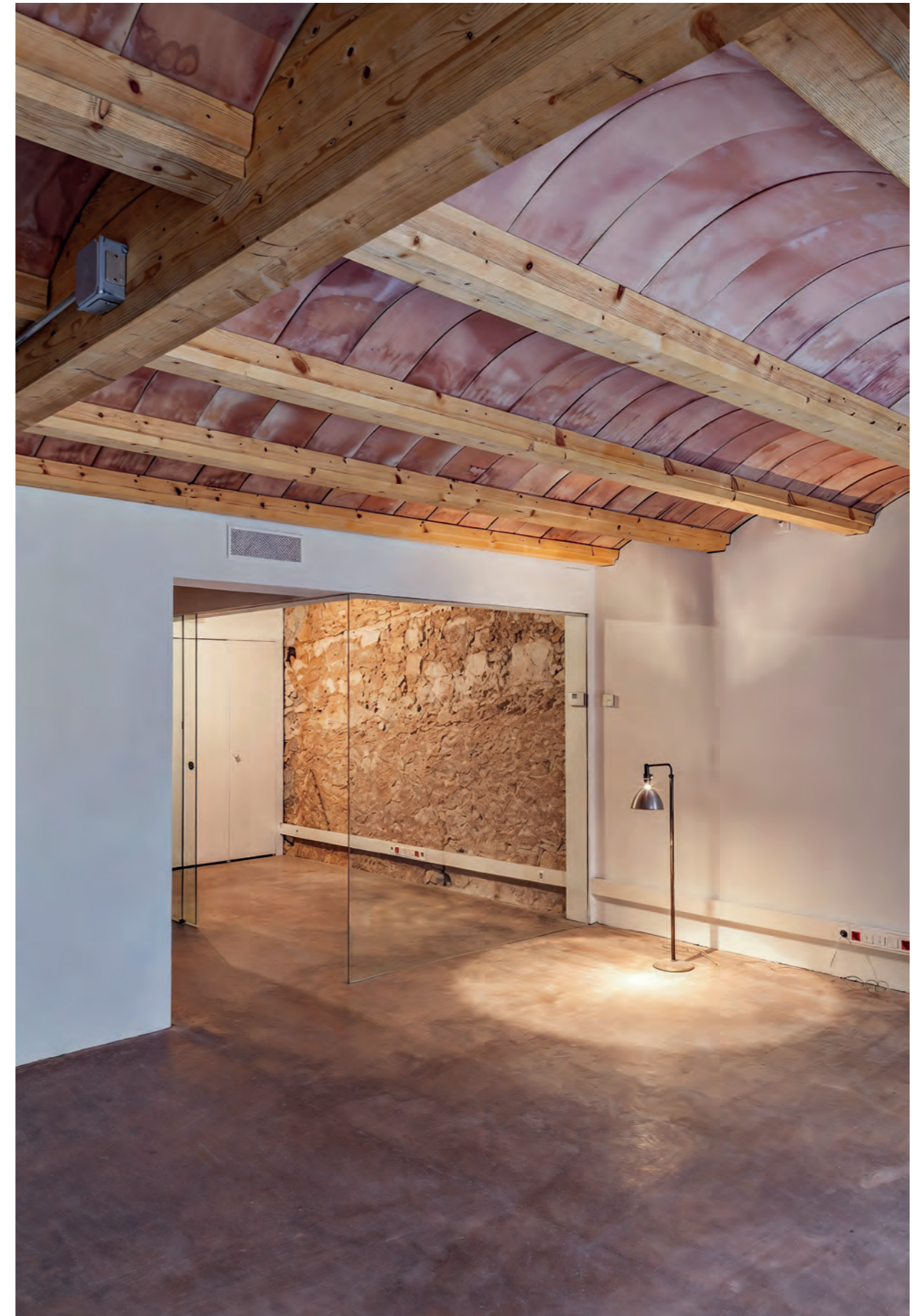
Espacios de trabajo: rehabilitación de oficina
