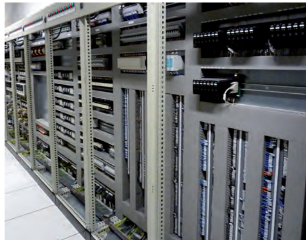
Fabricantes de maquinaria
