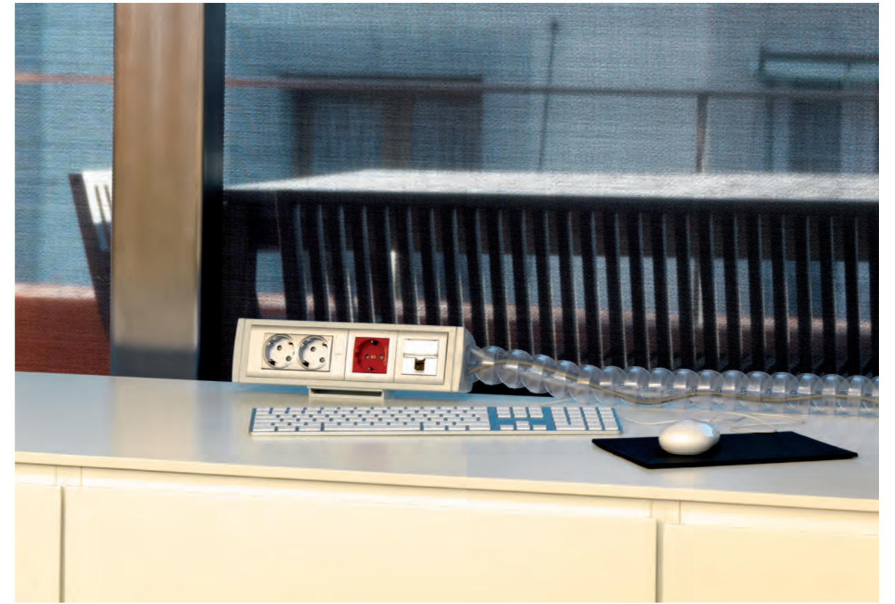
Puesto de trabajo: oficina
