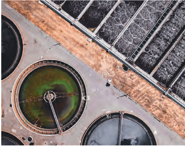
Tratamiento de aguas
