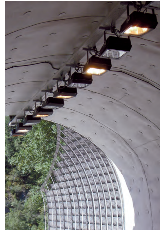
Infraestructura viaria: túnel
