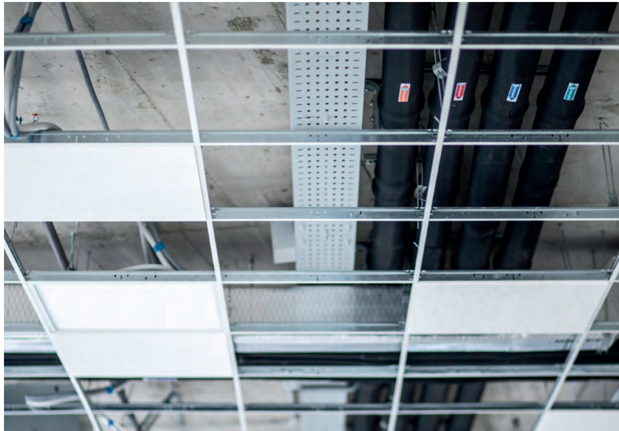
Espacio de trabajo: oficina
