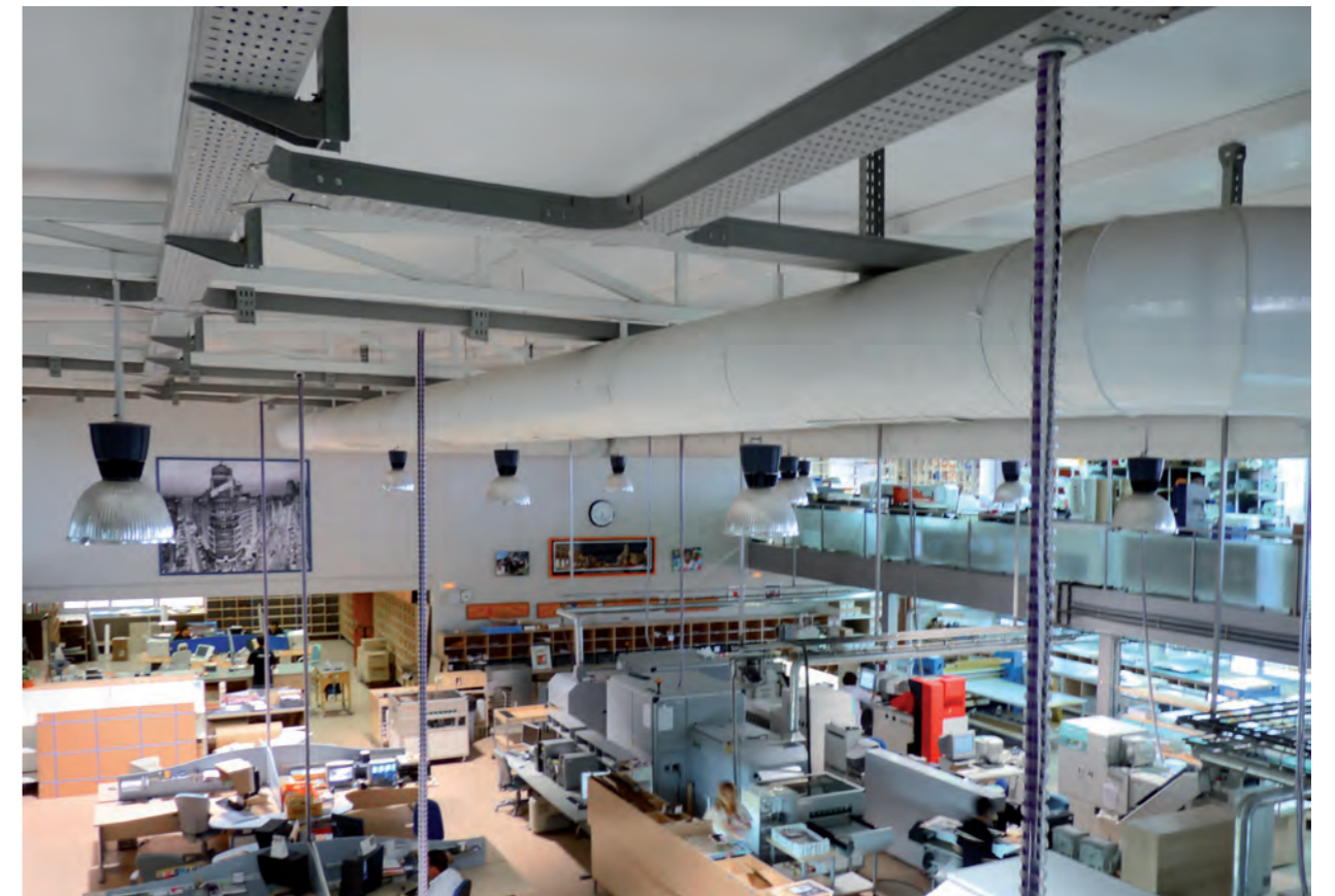
Nave industrial: oficina
