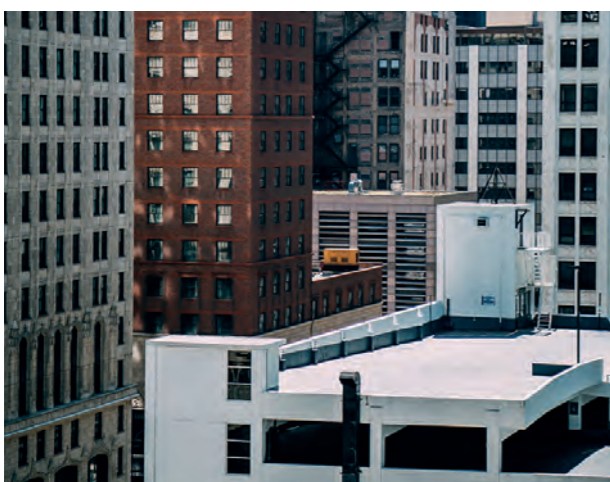
Instalaciones en azoteas
